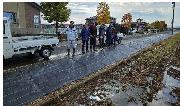
防草シート敷設
