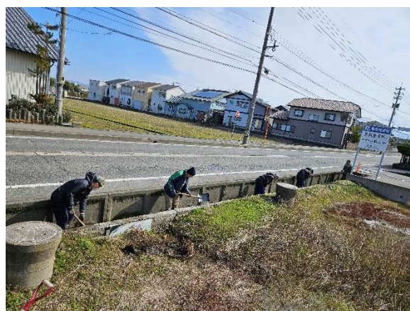
排水路の泥上げ
