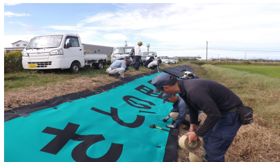
文字入り防草シート張り
