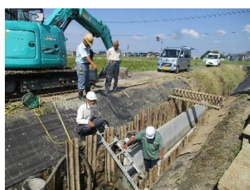
長寿命化による排水路工事
