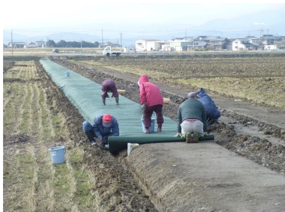
管排水路防草シート設置
