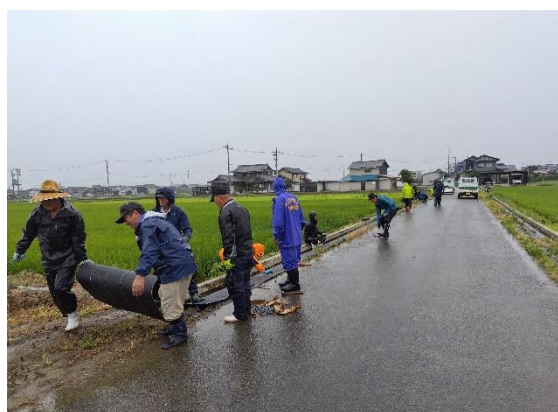
(4) 防草シート貼り
