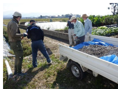
11月 水路の補修
