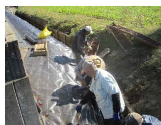
水路の軽微な補修
