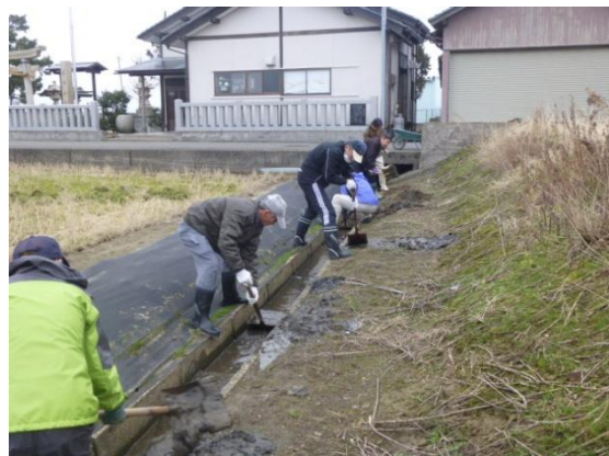
水路の泥上げ
