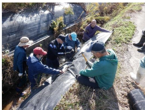
11月 水路法面の防草シート貼付
