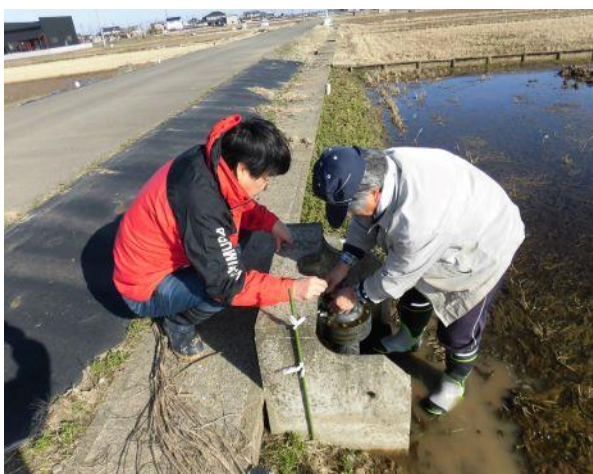
給水栓点検補修(3月)
