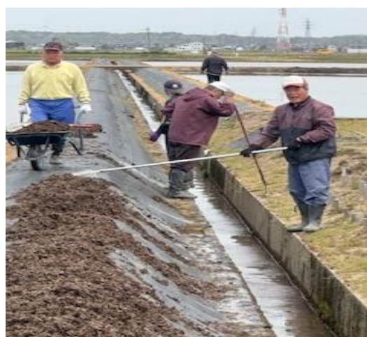
防草シートの設置作業
