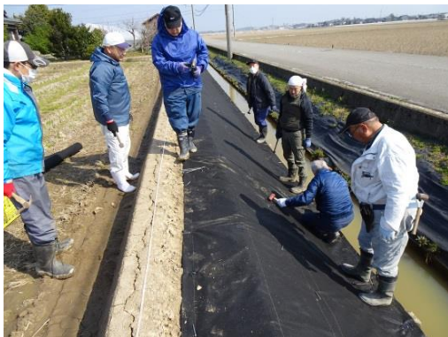
法面の防草シート貼り (11月~3月)
