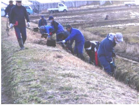
排水路の泥上げ
