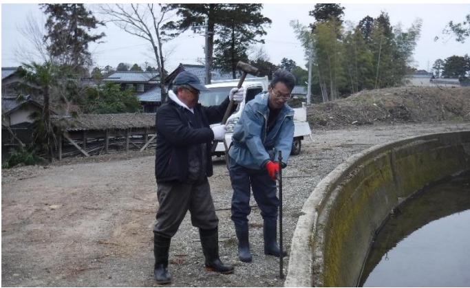
獣害軽減対策電気柵設置作業
