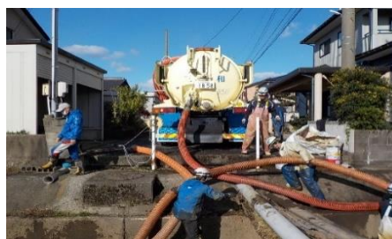
泥上げバキューム作業
