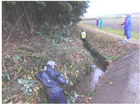
排水路法面の雑木伐採
