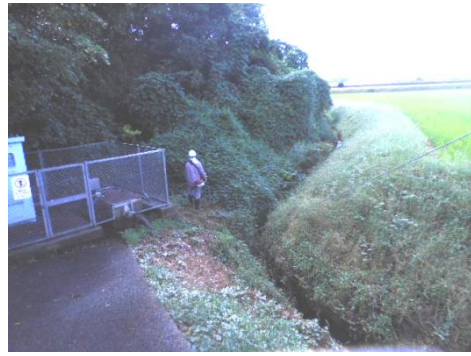
排水路法面の草刈り
