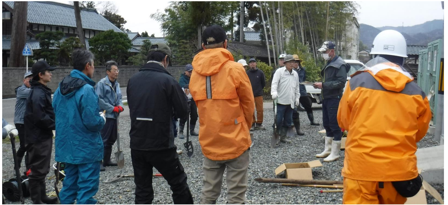
獣害軽減対策電気柵設置作業等の打ち合わせ (2024/3/17 撮影)
