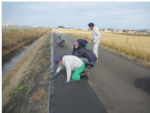
上部のアスファルトシート は、ガスバーナの熱で道路舗 装面に接着させ、さらにピン を打つ。
