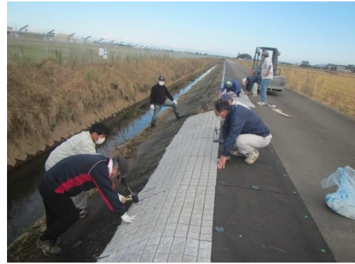
上部のアスファルトシート は、ガスバーナの熱で道路舗 装面に接着させ、さらにピン を打つ。
