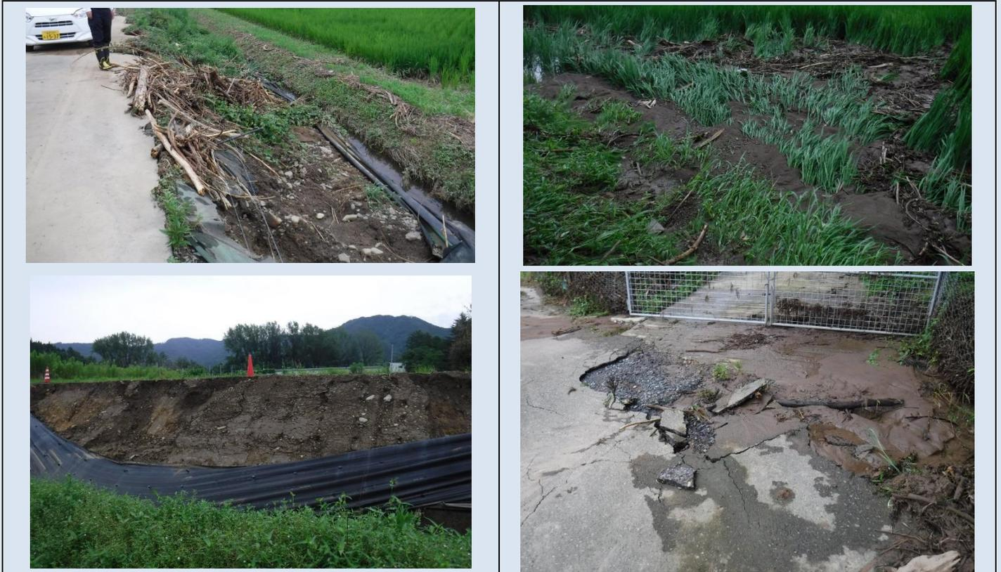
排水路の法面・農道が崩壊しました。流木・土砂などが農地に堆積しました。
