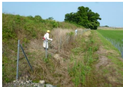
防草シート貼り
