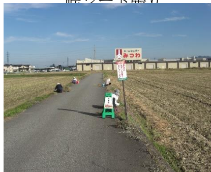
畦シート張り
