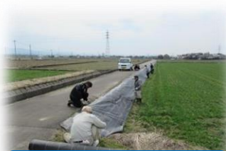
防草シート張り
