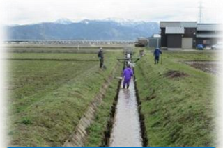
水路の泥上げ
