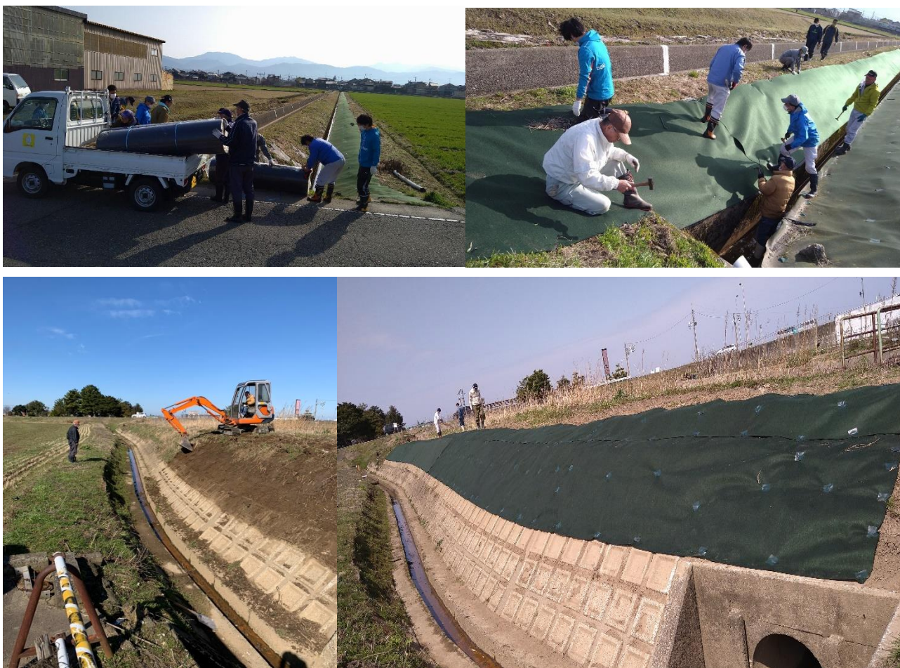
防草シート施工 3月に排水路法面を中心に施工
