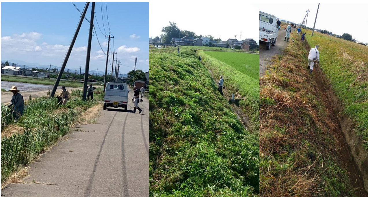
草刈り風景 夏に2回実施 防草シート施工前などに実施
