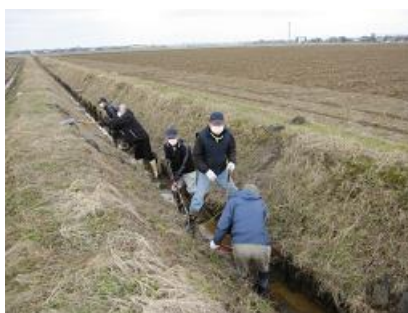
法面、暗渠排水の補修
