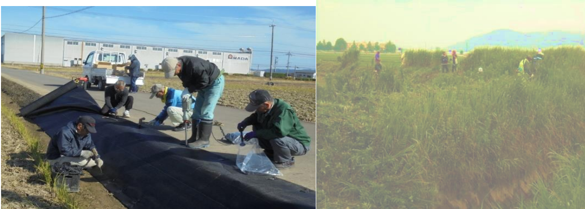
防草シート貼り付け作業
