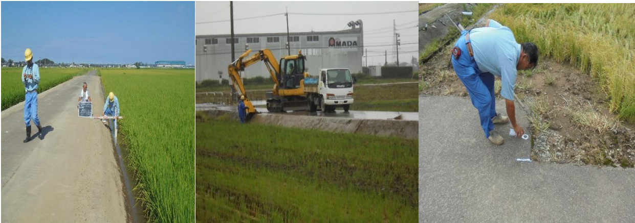
防草シート貼り付けに向けた農道側面工事
